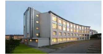
Hôpital de la Providence 1859/2012
